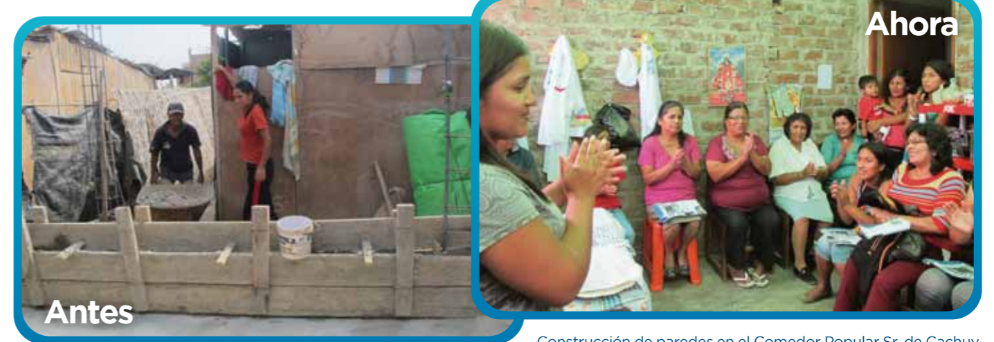
Construcción de paredes en el Comedor Popular Sr. de Cachuy.
